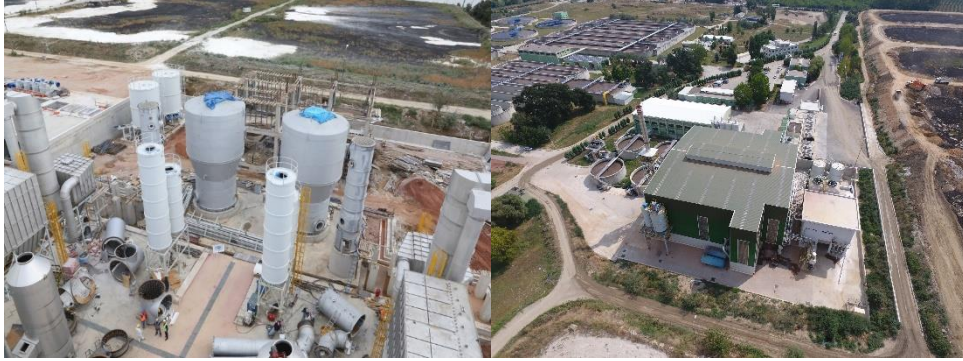
Resim 8: BUSKİ Arıtma Çamuru Yakma Tesisi
