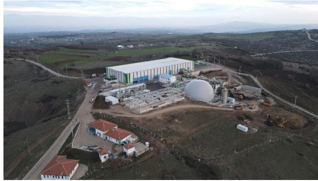
Resim 10: İnegöl Düzenli Katı Atık Depolama Sahası Enerji Üretim Tesisi
