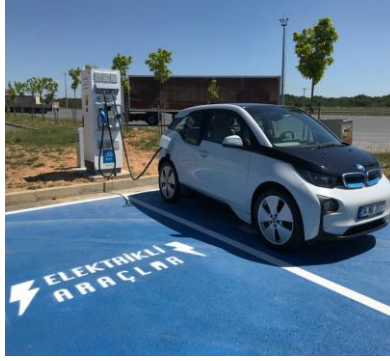
Resim 5: Bursa'da Elektrikli Araç Şarj İstasyonu
